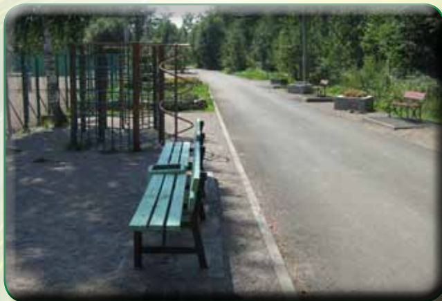
В 2011 году был осуществлен текущий ремонт дорог нашего поселка: ул.Тюрисевская, ул.Вокзальная, Почтовый пер., Приморское ш., 617.
